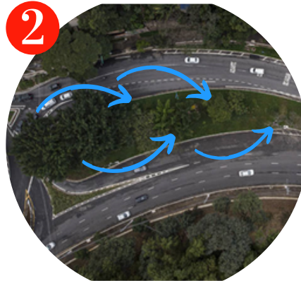
Figuras 99_ Canteiro central com técnica de drenagem
