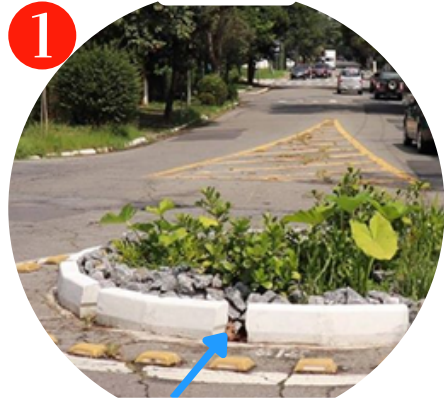
Figuras 98_ Rotula com técnica de drenagem
